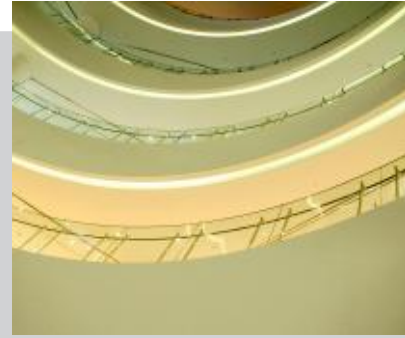
Kontur-Beleuchtung mit AluLED
